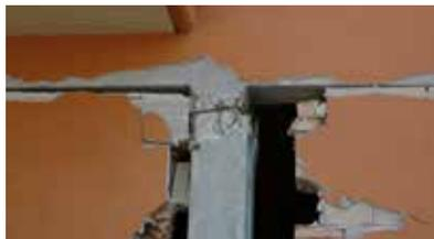
Rottura a taglio di pilastro
