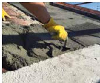
L'elevato contenuto di fibre consente di utilizzare il prodotto con un'armatura tradizionale estremamente ridotta o addirittura senza, così come in accordo al documento tecnico di riferimento CNR DT 204/2006. Lo spessore di applicazione di **PLANITOP HPC** è variabile mediamente tra i 20 e 40 mm.
