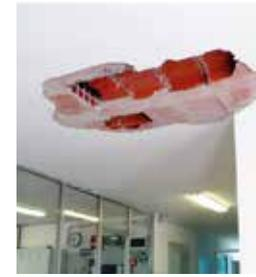
Il terremoto dell'Aquila del 2009 ha messo in rilievo l'importanza del rischio del ribaltamento degli elementi non strutturali, quali tamponamenti e tramezze, a causa delle sollecitazioni indotte dal sisma. Per tale problema, benché già noto, si è purtroppo rivelata la necessità di ulteriore attenzione e non a caso proprio le fotografie del sisma dell'Aquila sono diventate tra le più familiari agli addetti ai lavori.
