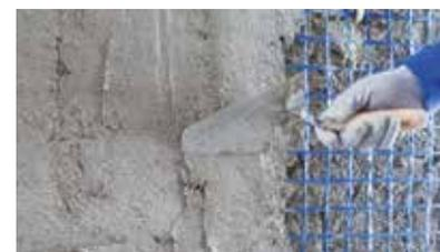
Applicazione del rinforzo per incremento di resistenza a taglio-trazione e compressione
